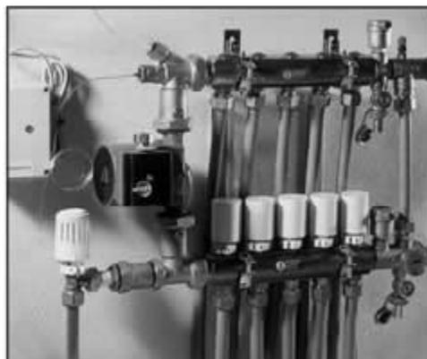
Fig. 21 - Distribution colectores de distribución for heating floor
